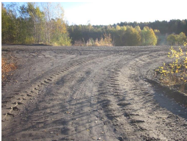
Figur 18: Til dels dårlig grusvei.
