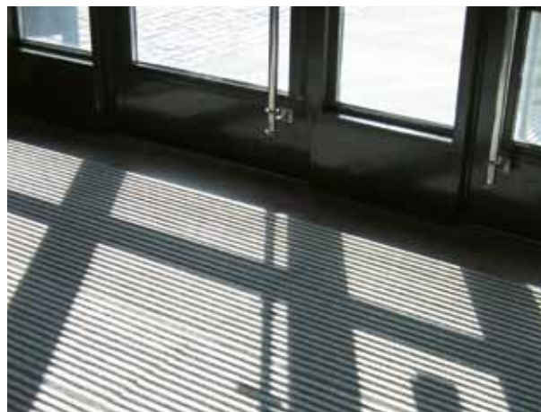
Fig 4.45 Granitt med freste spor som avtørkingsflate. Elegant og effektivt. Foto: Sveriges Stenindustriförbund.
