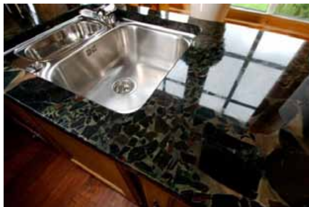
Fig 8.8 Undermontert oppvaskkum på benkeplate av breksje (Black Beauty). Foto: Steinriket Norge AS
