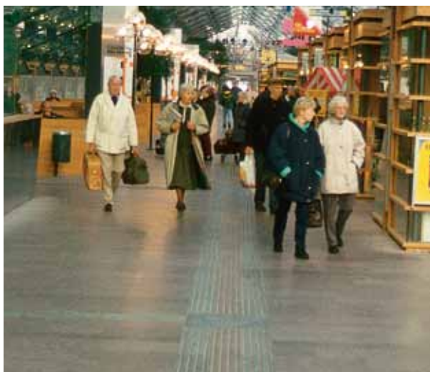
Fig 4.46 Plater med forskjellig farge og med freste spor innlagt for å veilede synshemmede, er samtidig et dekorativt innslag i miljøet. Foto: Sveriges Stenindustriförbund.
