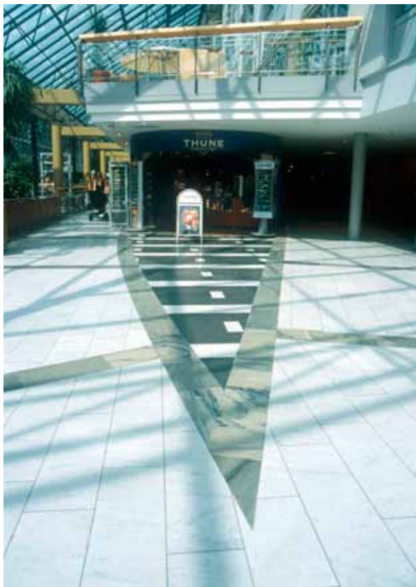
Fig 4.3 Gulv med finslipt marmor og skifer. Solsiden Kjøpesenter, Trondheim. Foto: SINTEF Byggforsk.
