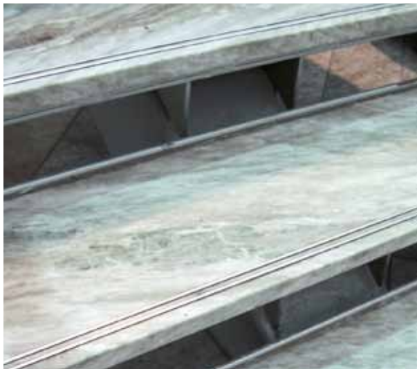
Fig 5.22 Metallister innfelt i steinen kan gi skliskikkerhet og god, visuell effekt. Foto: Sveriges Stenindustriförbund
