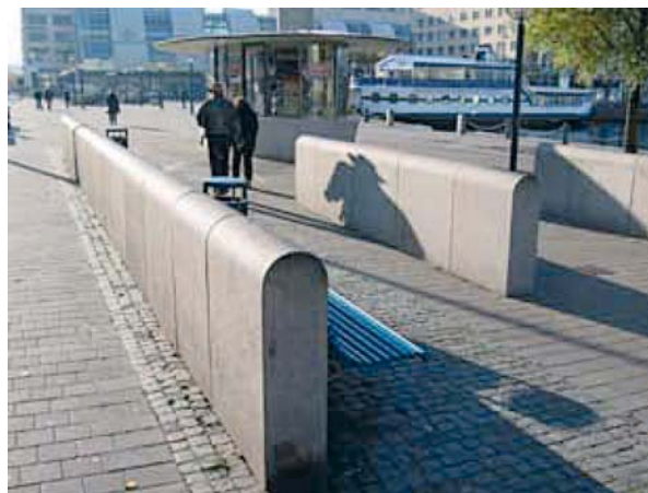
Fig 8.2 Blokksteinsmur av flammet granitt.
