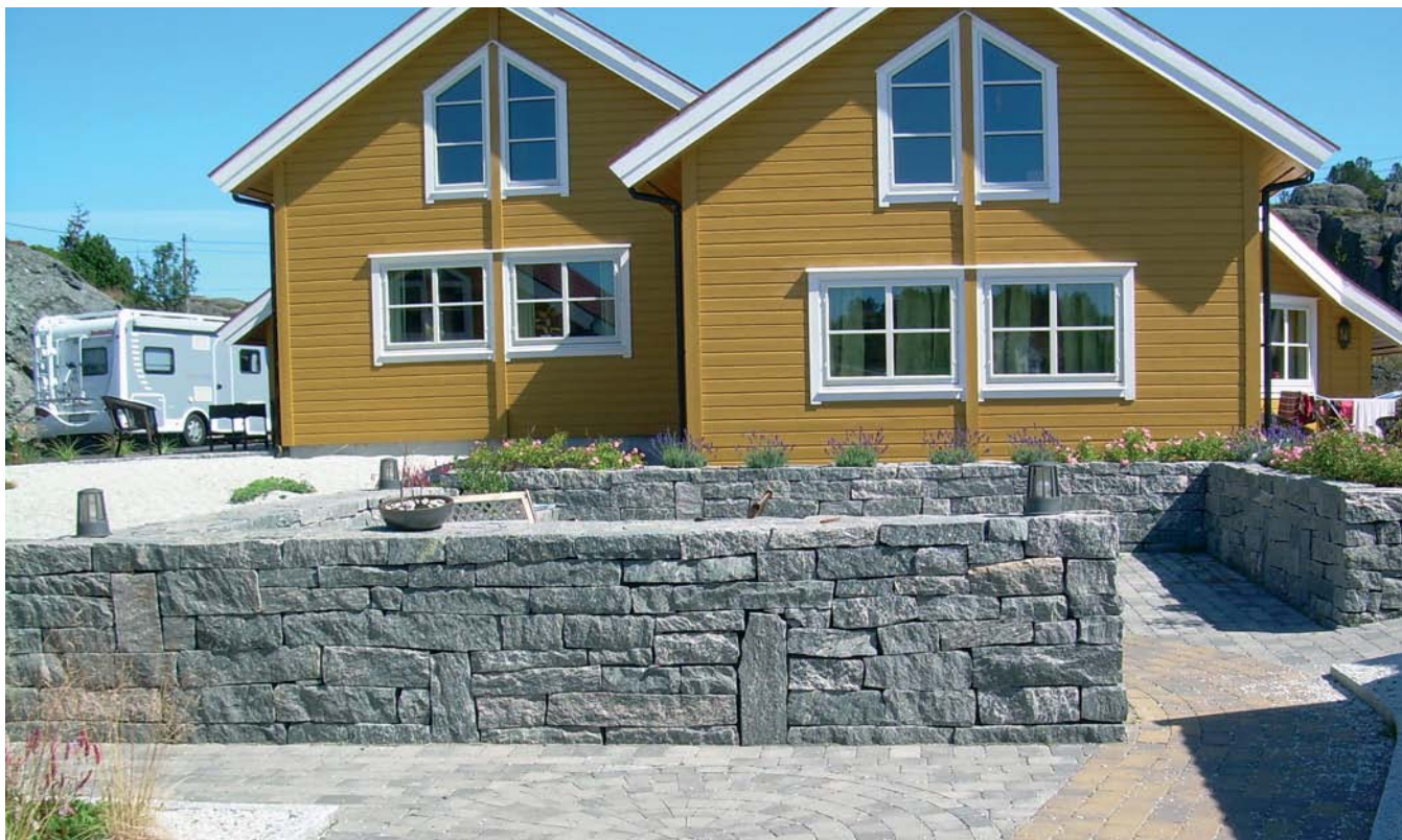
Tosidig mur forblendet med klipt murstein fra Førde Granitt AS. Foto: Øystein Menes
