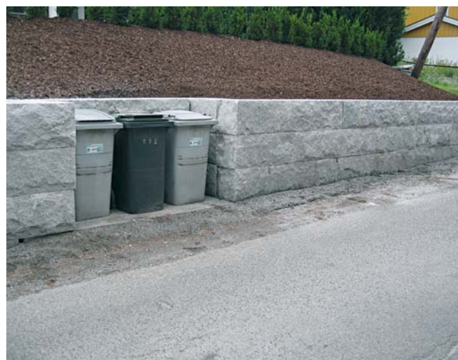
Råhugd tørrmur med sagde fuger. Foto: Jogra
